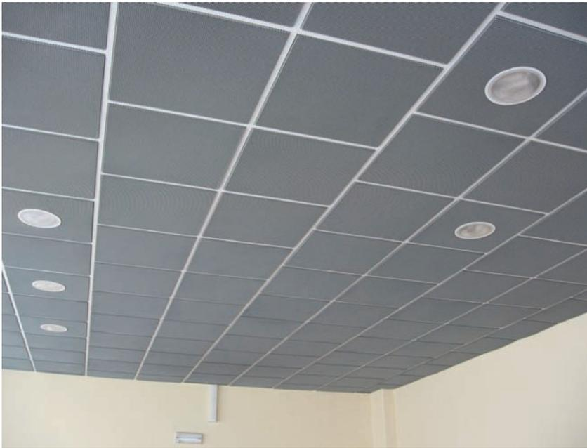
Die Streckmetallkassetten können versetzt verlegt werden, wie auch verschiedene Modulgrößen kombiniert werden. Bei der Kombination der Modulgrößen ist darauf zu achten, dass entweder nur Module, welche durch 100 teilbar sind oder durch 312,5 teilbar sind gemeinschaftlich verlegt werden. Ansonsten müssten bei den T-Schienen Sonderschlitzte eingestanzt werden.
