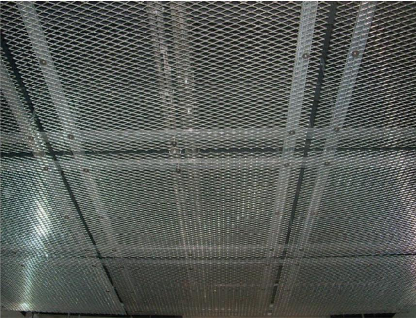
Das VES-Schraubsystem VES-K50 ist ein preiswertes Deckensystem mit erhöhter Anforderung gegen Vandalismus (zum Beispiel für Bahnhöfe, öffentliche Unterführungen u.s.w.).
