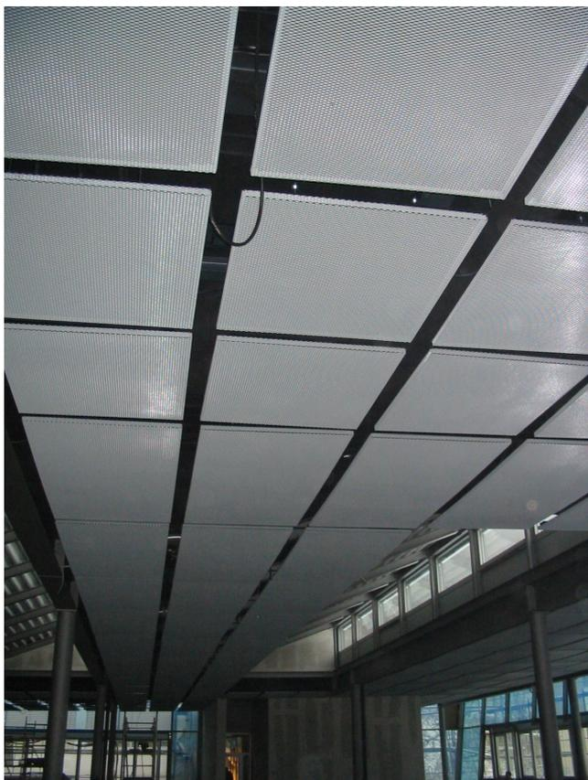
Dieses Deckensystem kann mit allen Kantungsarten, wie auch Seite 10 dieses Prospektes beschrieben gefertigt werden. Empfohlen wird aus statischen Gründen die Kantungsarten E1 und E5.
