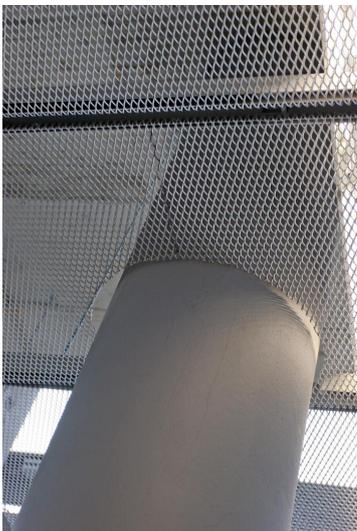
Ausklinkungen in den Deckenplatten, ob rechteckig, rund, an der Längsseite, Stirnseite oder an der Ecke.
