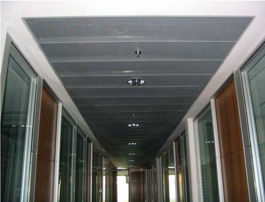
Flurdecken aus Streckmetall nach System VES-L100-WA ist das bekannteste und einfachste Streckmetall-Deckensystem für Flure, da man hier die Elemente jederzeit aus Revisionsgründen aus einem Wandwinkel herausnehmen und wieder einlegen kann.
